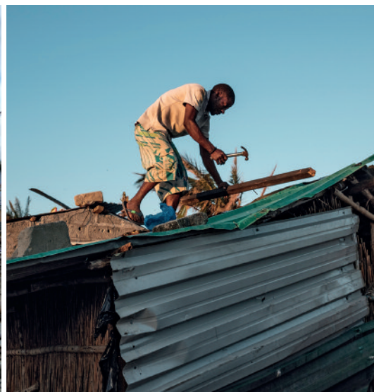
Wiederaufbauarbeiten nach dem Zyklon Idai im Jahr 2019 in Mosambik
